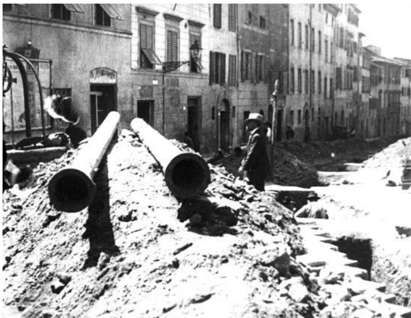
Una vecchia foto (1919) che mostra i lavori sulle tubature che portano l'acqua del Vivo in Città. Da quel momento le antiche fonti ed i bottini cominciarono a perdere importanza
