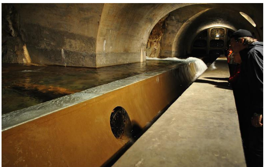
L'interno delle strutture dell'acquedotto
